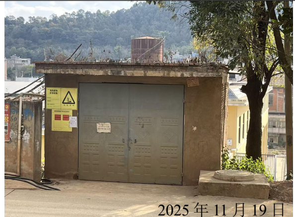
现有危险废物贮存库
