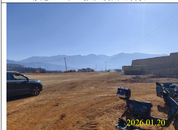
已平整场地区域现状
