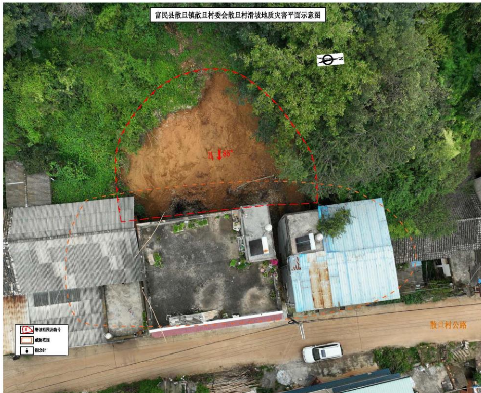
图 1-1 散旦村滑坡现状平面图
