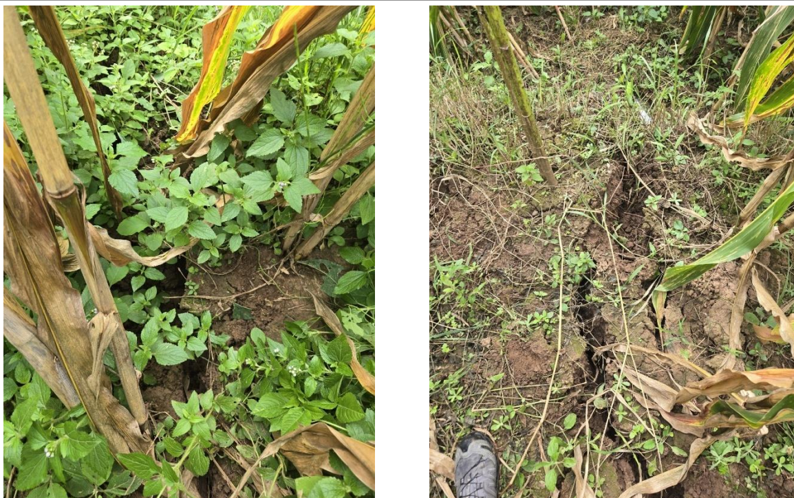
图 3.3-1 西冲村滑坡区裂缝照片
