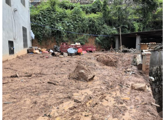
照片 3-4 泥沙冲入居民房屋①
