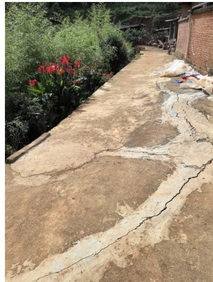
照片 3-2 高家凹 H1 滑坡滑动后坡体现状
