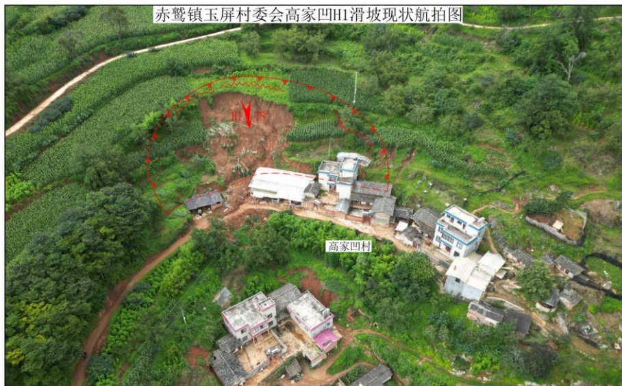
图 1-1 赤鹫镇玉屏村委会高家凹 H1 滑坡现状航拍图
