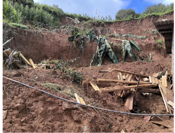
照片 3-2 高家凹 H1 滑坡滑动后坡体现状
