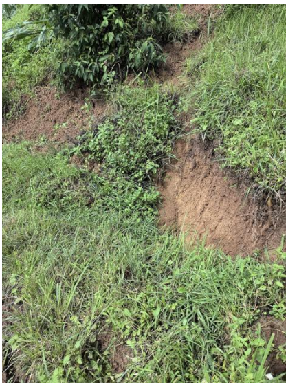
照片 3-3 H1 滑坡后缘裂缝错台
