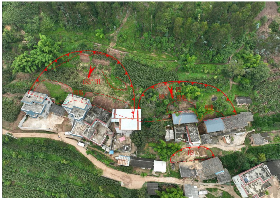
图 3-1 庙山村 H1、H2、H3 滑坡现状航拍图
