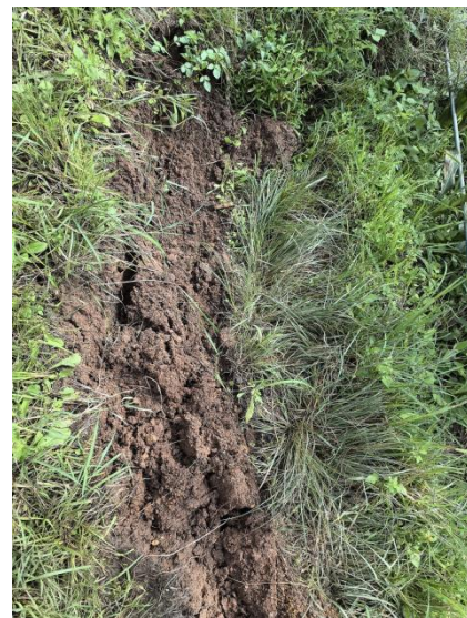
照片 3-4 H1 滑坡后缘裂缝近照
