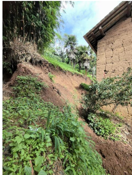
照片 3-2 H2 滑坡前缘滑动后现状
