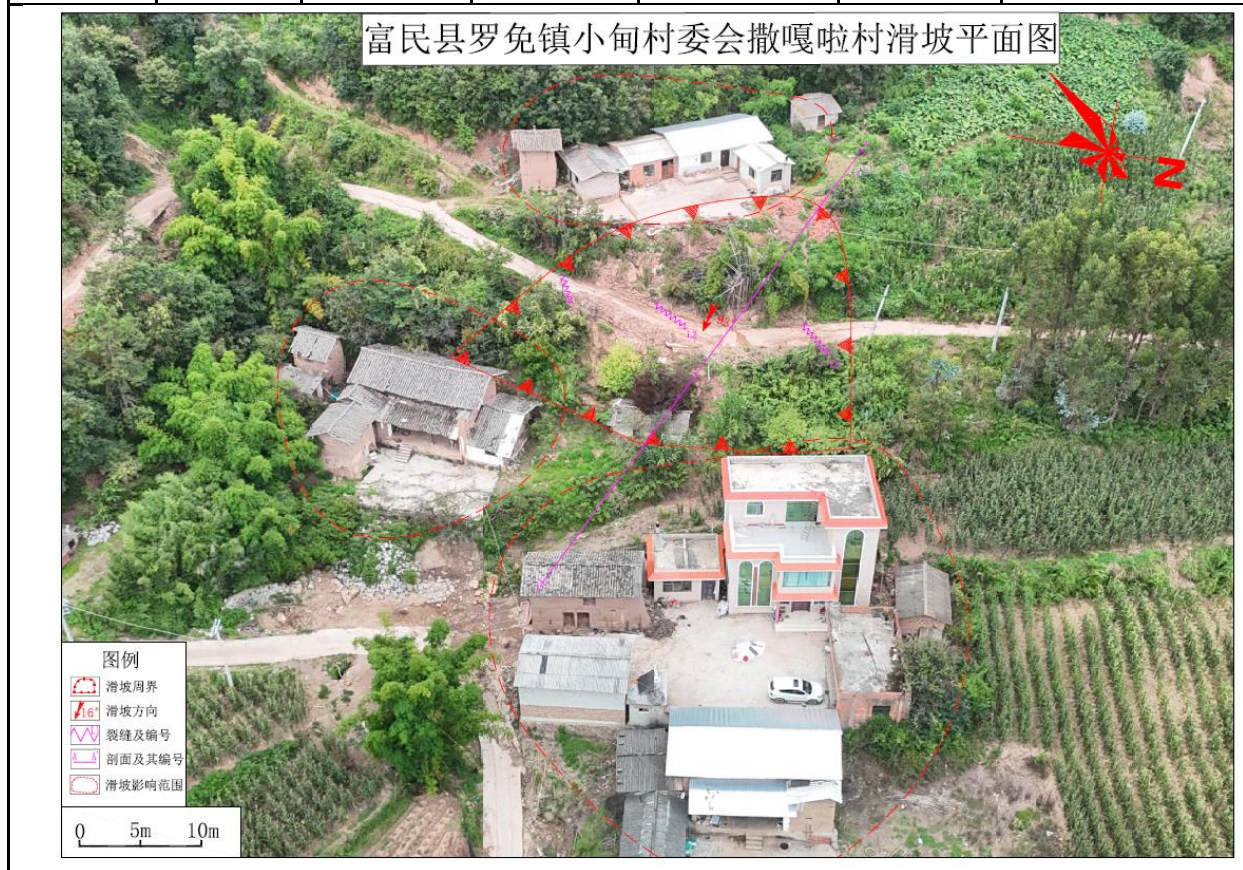
图 3-1 撒嘎拉村滑坡现状航拍图
