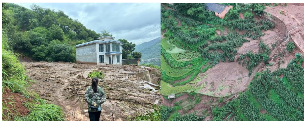
图 3.3-2 大麦地村 N2 泥石流现场照片
