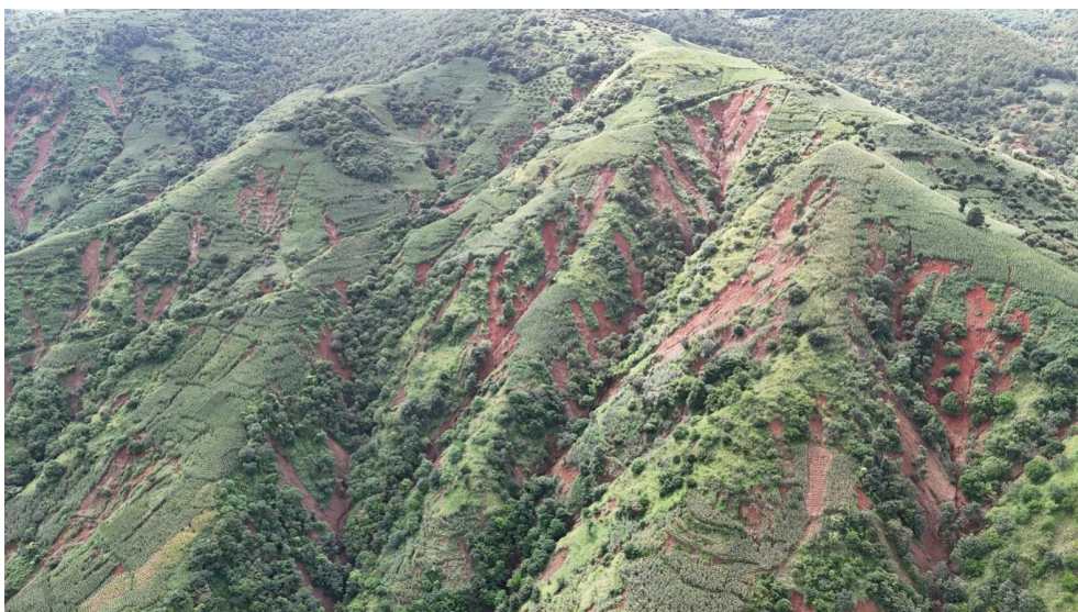
图 5.2-2 大麦地村 N1 泥石流物源区坡面侵蚀
