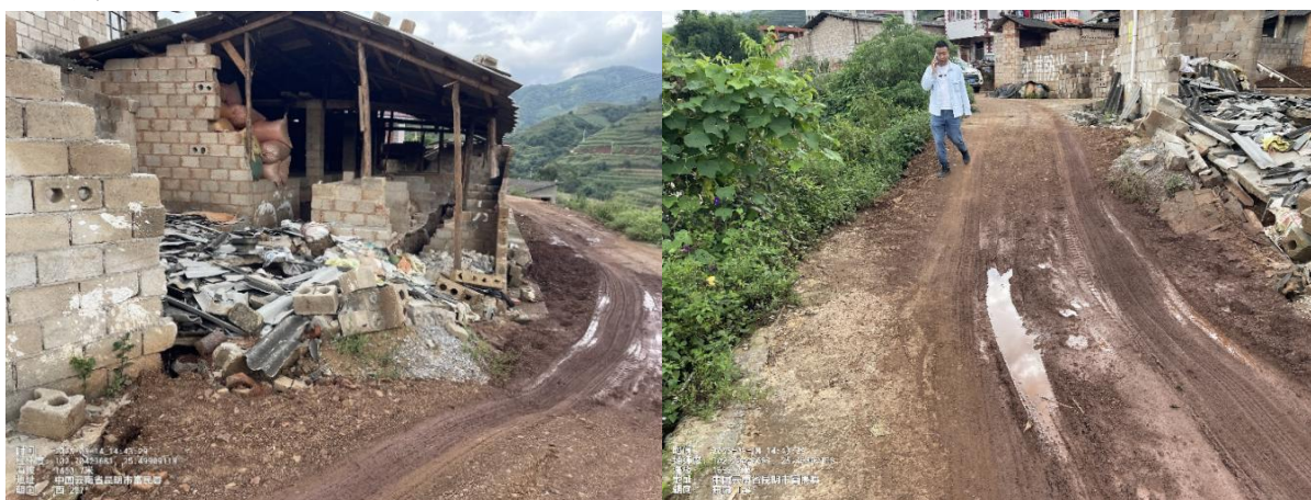
图 4.3-1 大麦地村滑坡部分区域现场照片
