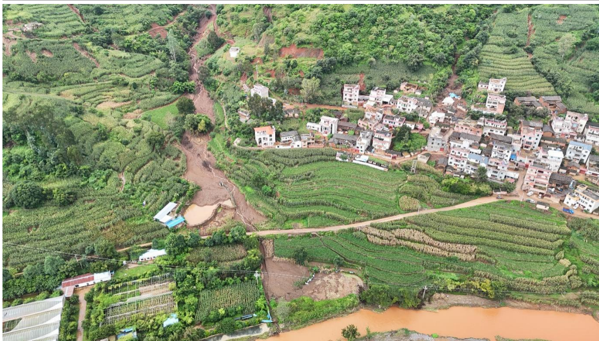
图 3.3-1 关宝箐泥石流沟口损毁农田及生产用房
