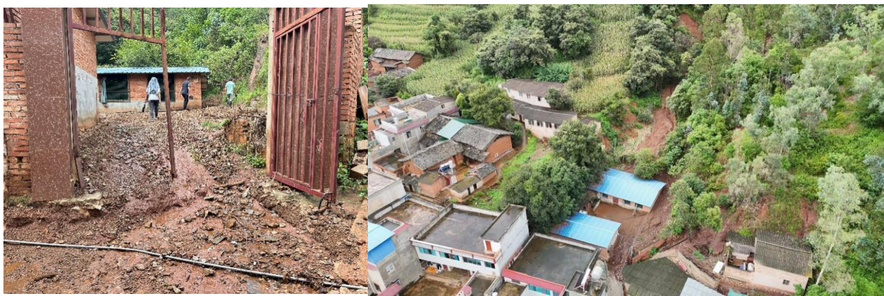
图 3.3-3 花箐泥石流流域居民区淤积泥沙
