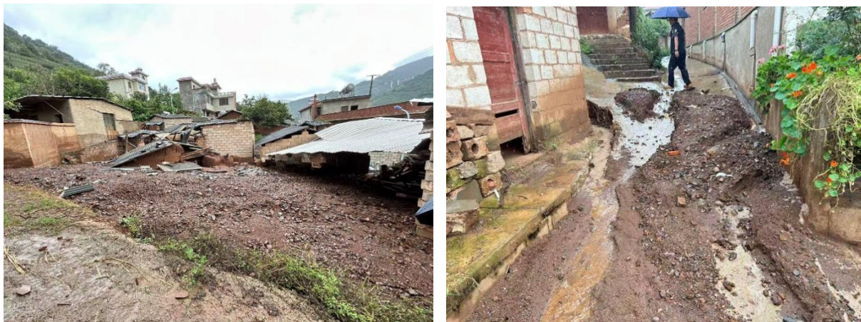
图 3.3-2 花箐泥石流流域损毁房屋
