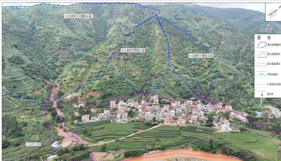
图 3.1-1 富民县款庄镇徐谷村委会小白坡村泥石流现状图
