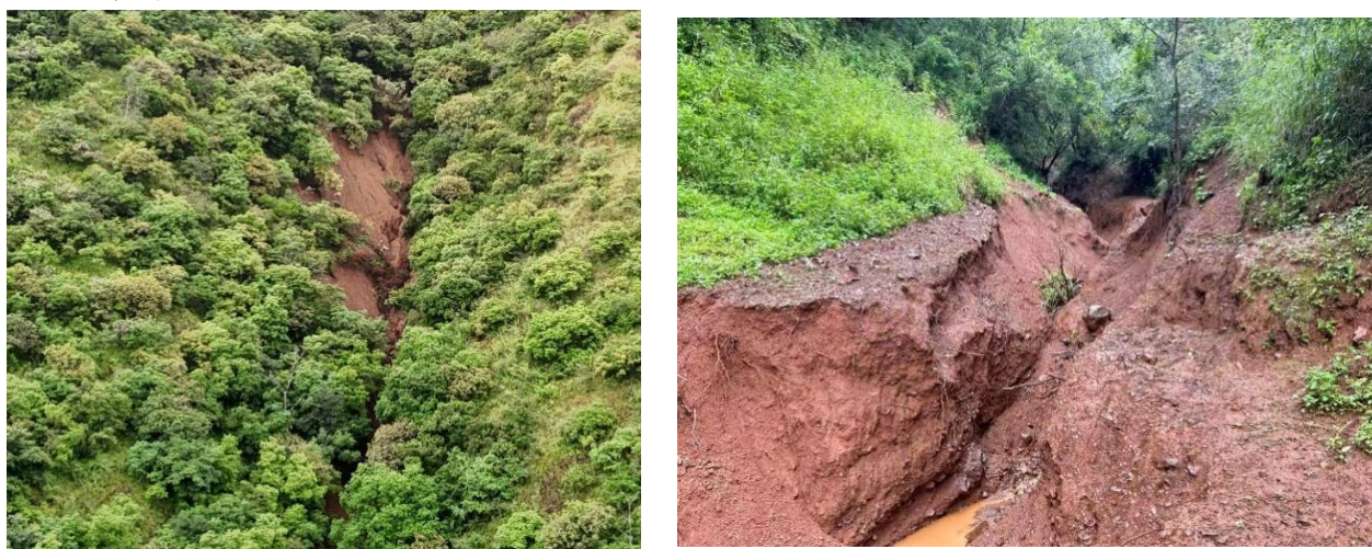
图3.2-3花箐泥石流物源区沟岸垮塌
