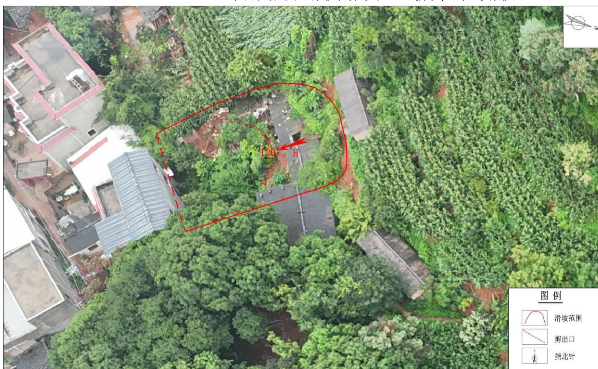
图 4.1-1 富民县款庄镇徐谷村委会校场坝村滑坡现状图
