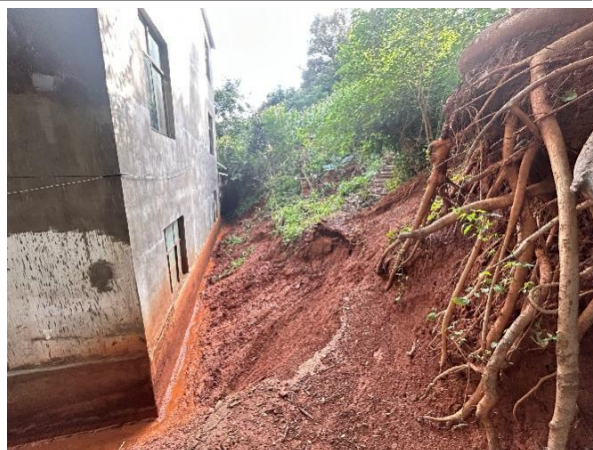
图4.3-2 校场坝村滑坡前缘
