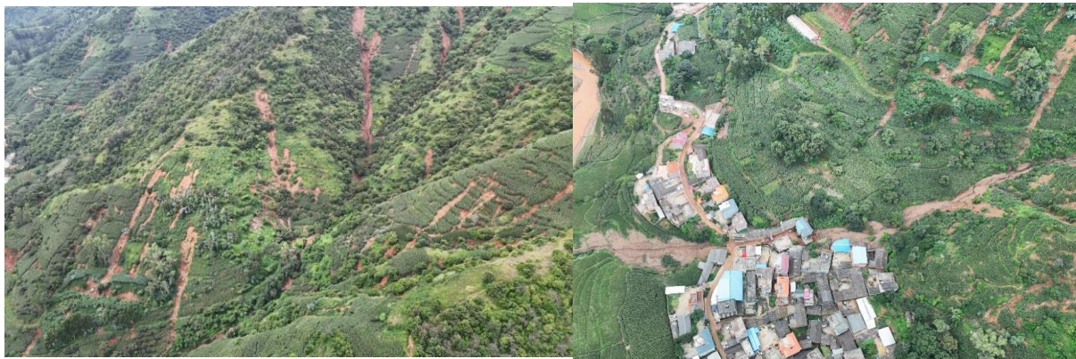
图 3.2-1 校场坝村 N1 泥石流物源区坡面侵蚀 图 3.2-2 校场坝村 N1 泥石流流通区中下游沟道
