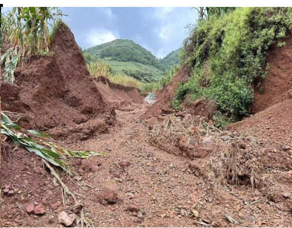
图 3.2-4 流通区中游本次泥石流深切割形成沟道
