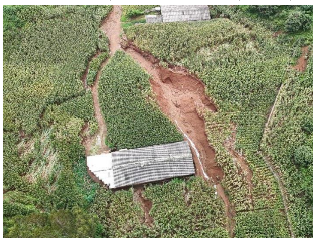
图 3.3-1 沙沟泥石流造成生产用房受损
