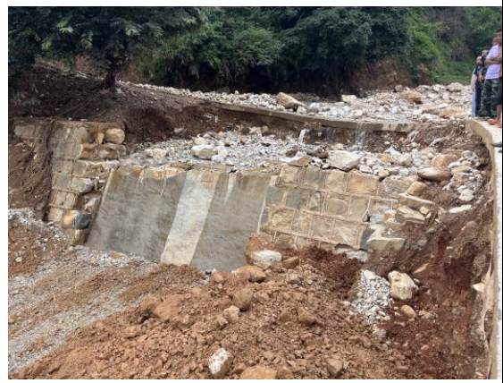
照片 3-6 1号坝坝体受损照片
