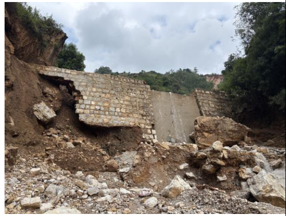
照片 3-6 1号坝坝体受损照片
